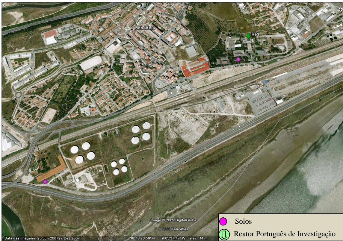
Fig. II.2 – Vista da área envolvente ao CTN, incluindo a localização dos pontos de amostragem de solos (no exterior e no interior do campus ).
